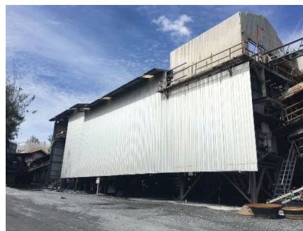
รูปที่ 2-4: การปิดคลุมโรงโม่หิน
